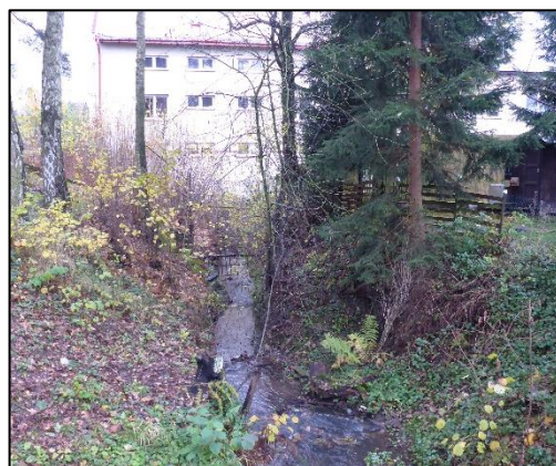
Obrázek 5-3: Nevhodná budova přes údolí potoka s nekapacitním zatrubněním
