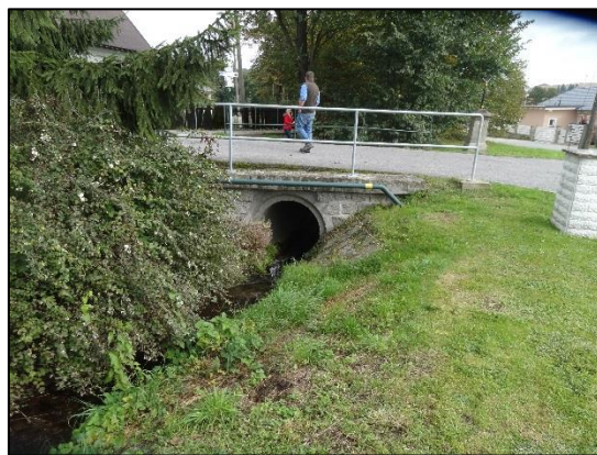
Obrázek 5-2: Nekapacitní koryto a propustek na příjezdu k nové zástavbě
