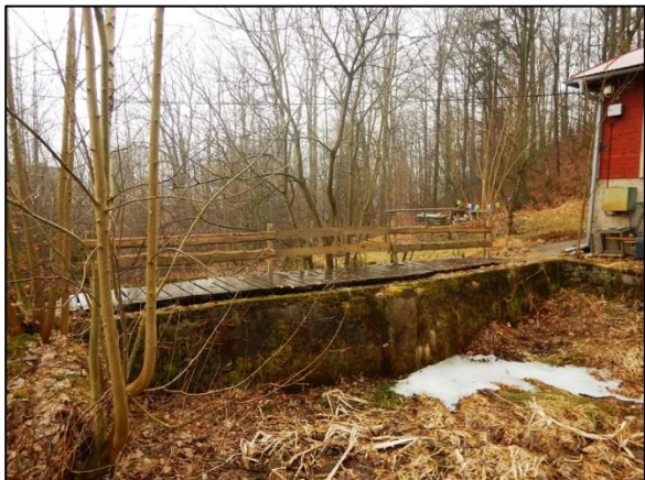
obr. 1 – poškozená zděná hráz horního rybníčku
