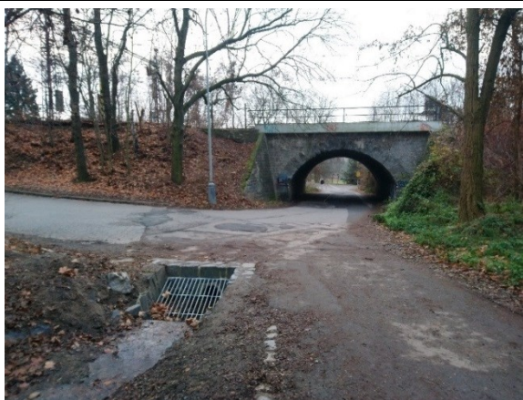
1. Kritický bod – vpust zatrubnění toku s česlemi, kde dochází k zanášení česlí a následnému povrchovému odtoku po komunikaci (18.12.2019)
