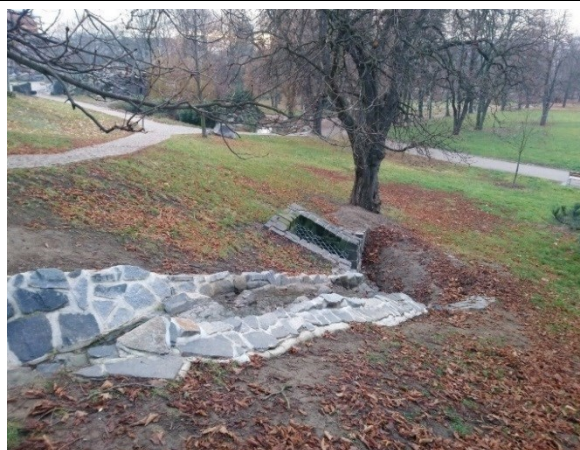
2. Opevněná výpust zatrubnění do parku Podviní (18.12.2019)
