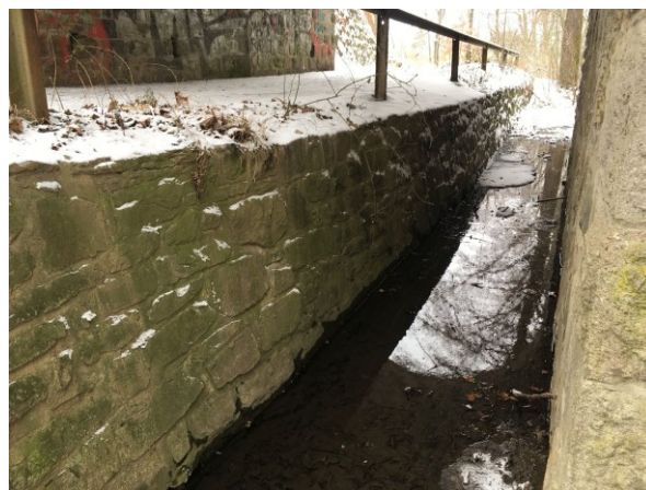
Koryto bezejmenného vodního toku vedené železničním podjezdem (IDVT 10245250), rozměr 1 x 1.5 m
